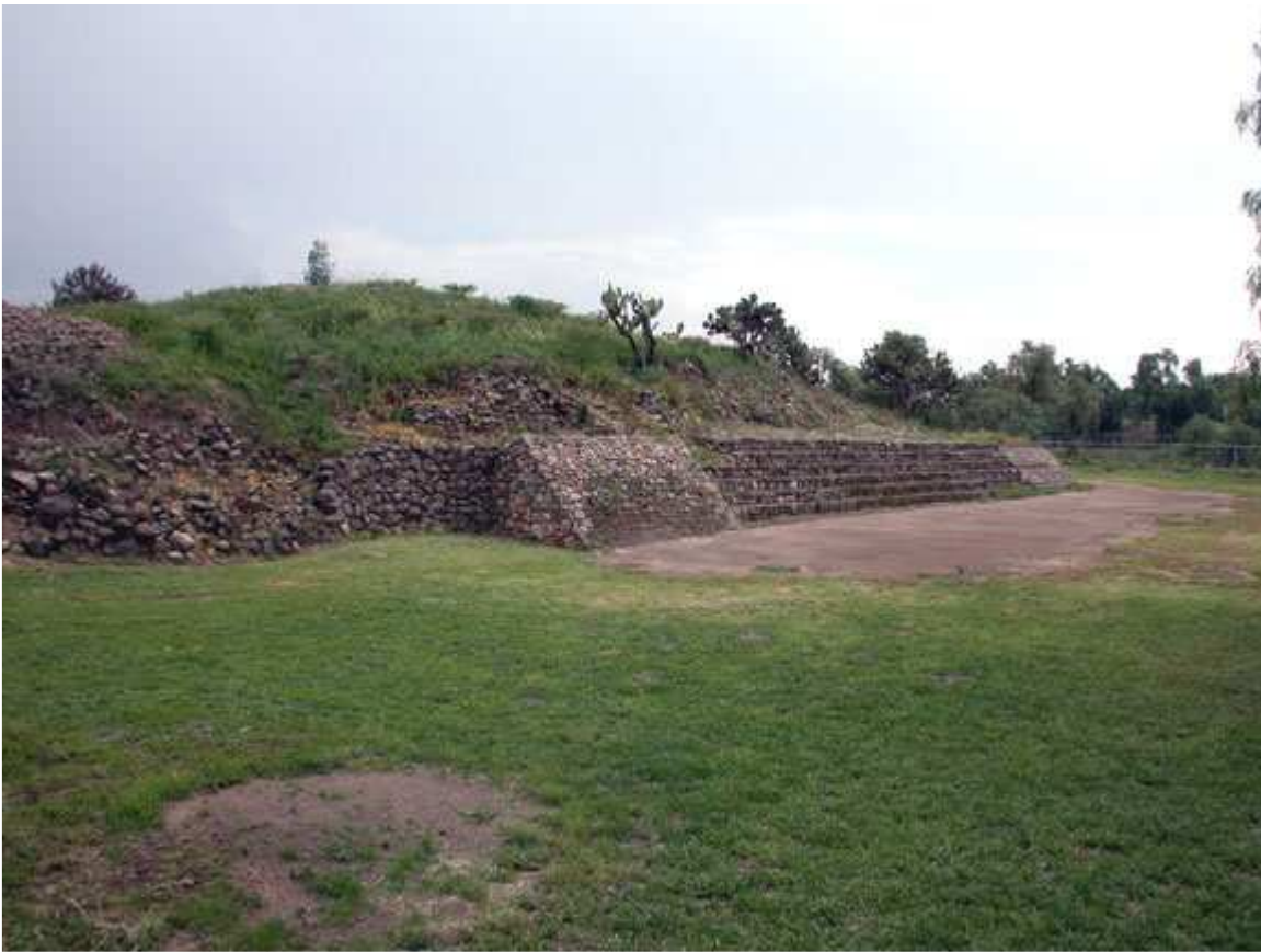
Figura 150. Edificio La Estancia en Huexotla (foto de Fernando González y González).
